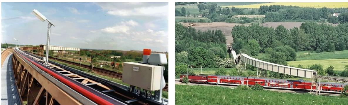
**Figura 4-17.** Transporte de desechos mineros Crossen y residuos de procesamiento a la planta de sedimentación industrial Helmsdorf con Pipe Conveyor
